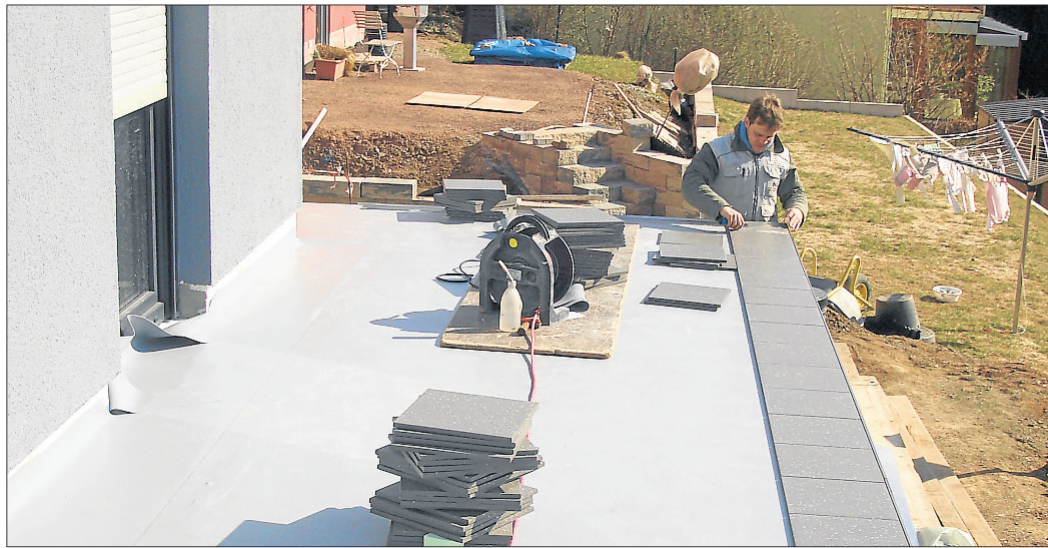
Mit einem neuen Verlegeverfahren für Fliesenbeläge im Außenbereich hat sich die Firma Rudolf Münkel um den Innovationspreis des Handwerks beworben. Foto: privat
